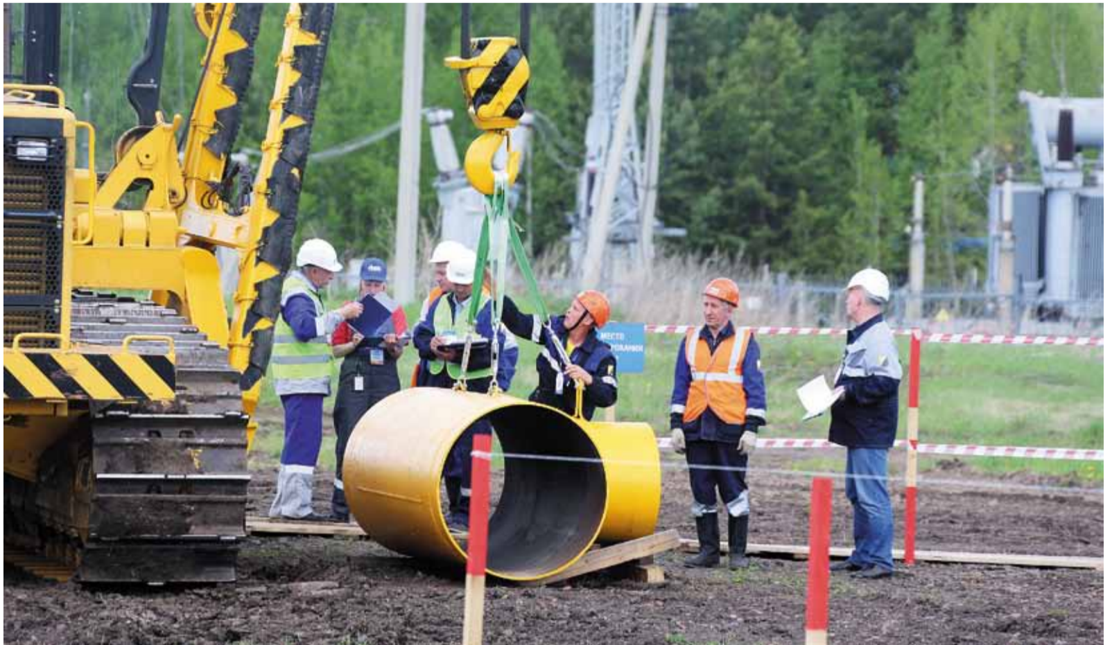
Конкурс машинистов трубоукладчика прошел на базе Юргинского ЛПУМГ
